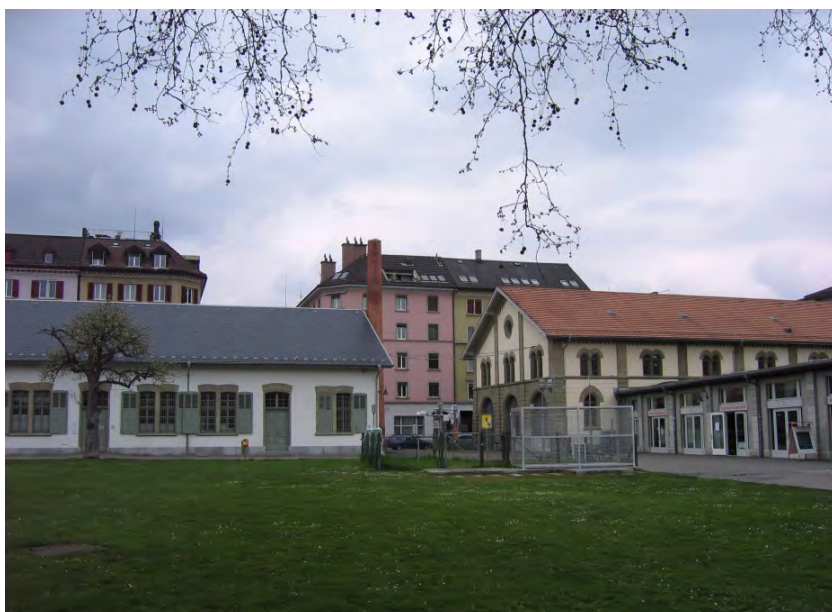
Abb. 2-43: Messstation Zürich, Zeughaushof
