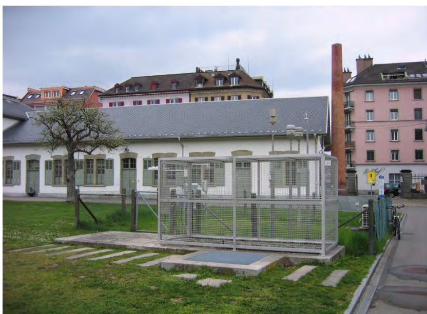
Abb. 2-44: Messstation Zürich (Messstation unterirdisch)
