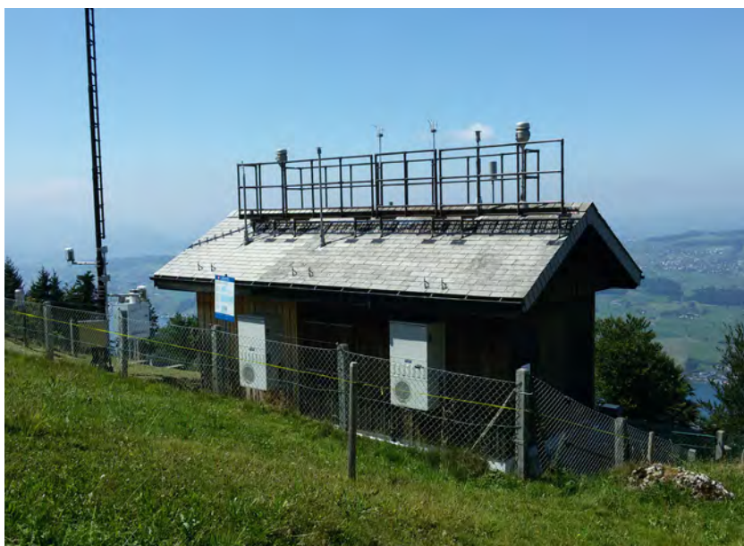
Abb. 2-35: Messstation Rigi mit neuem Dachaufbau (2015)
