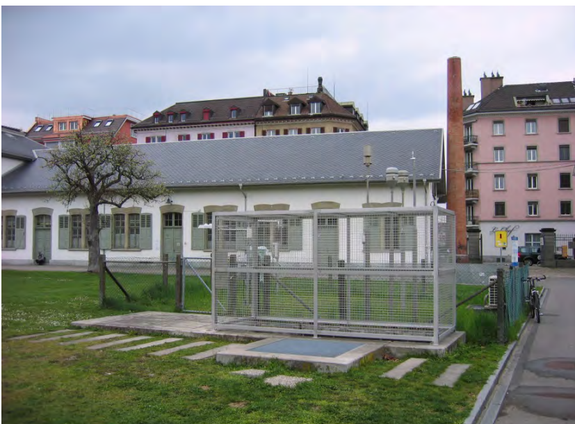
Abb. 2-44: Messstation Zürich (Messstation unterirdisch)
