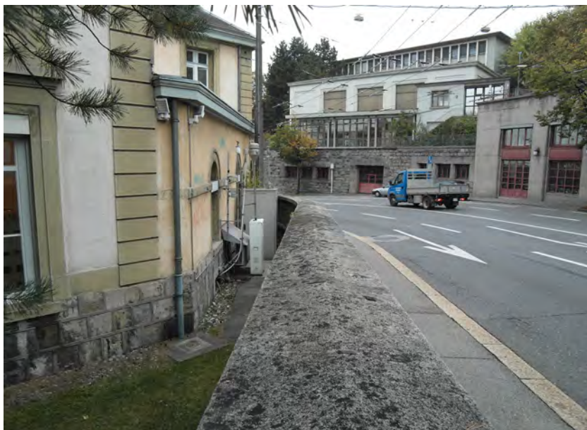
Abb. 2-22: Messstation Lausanne im Keller der Bibliothek „Pour tous“
