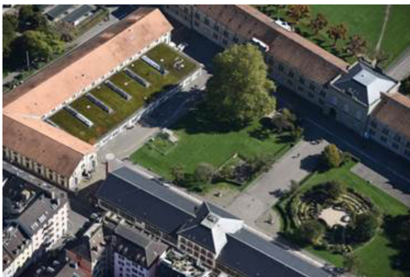
Abb. 2-45: Messstation Zürich, Zeughaushof
