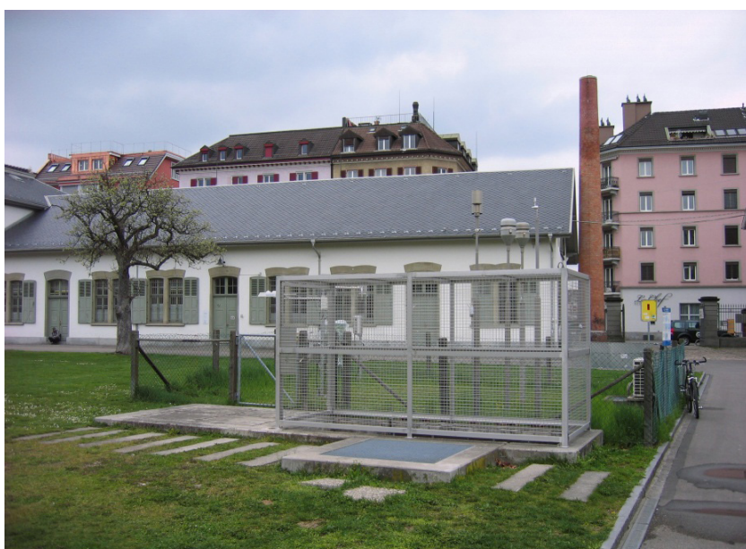
Abb. 2-46: Messstation Zürich (Messstation unterirdisch)
