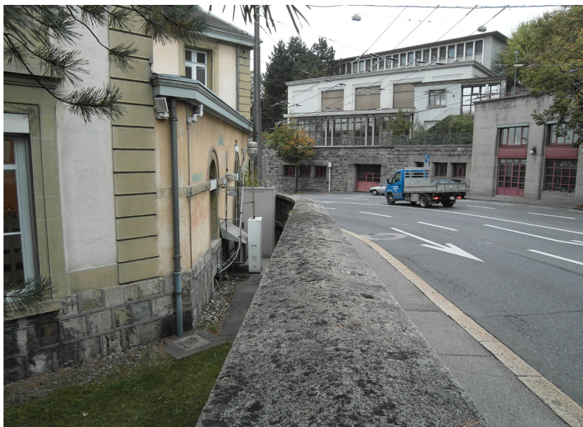
Abb. 2-24: Messstation Lausanne im Keller der Bibliothek „Pour tous“
