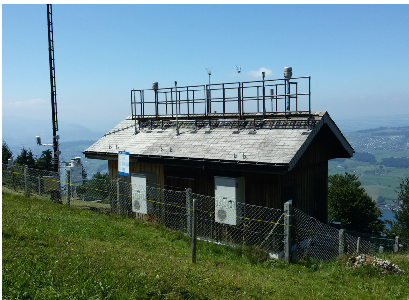
Abb. 2-37: Messstation Rigi (Blick gegen Nordwesten)
