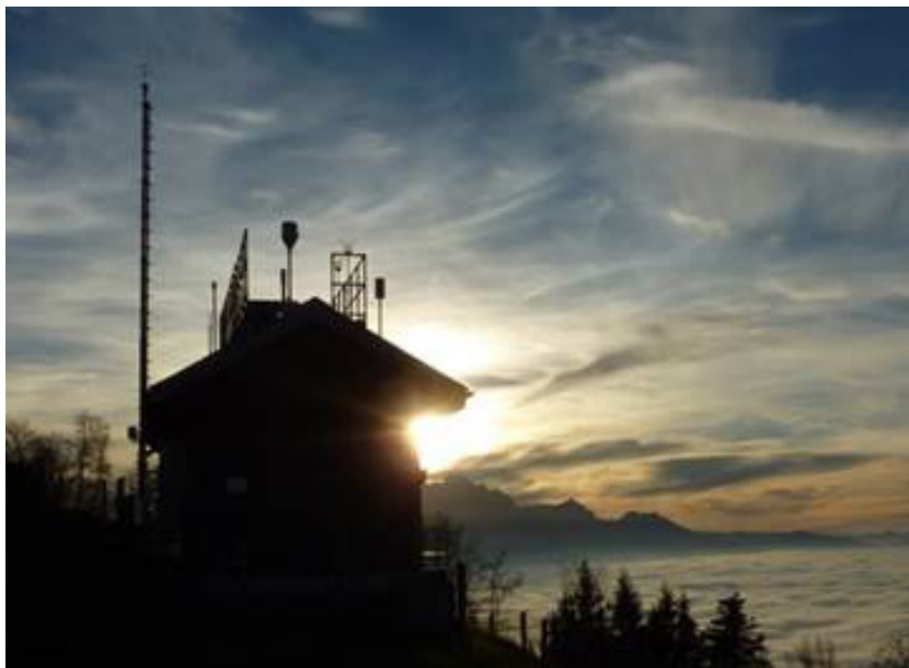
Abb. 2-36: Messstation Rigi (Blick gegen Westen)
