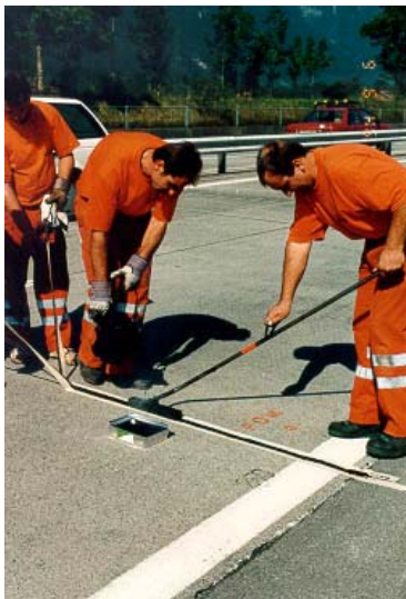
Réalisation d'un joint coulé à chaud.
