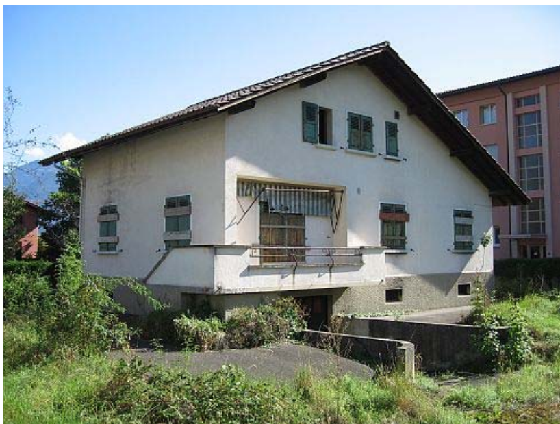
Das Abbruchobjekt in Monthey, an welchem Empa und EPFL Ende Oktober dynamische Versuche durchführen werden.
