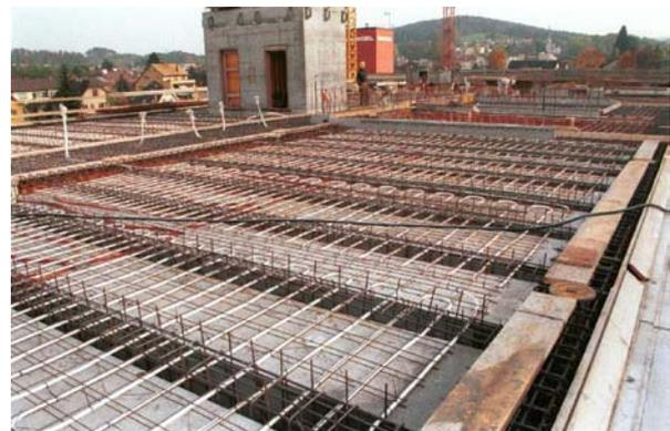
Thermoaktives Bauteil vor dem Betonieren.
