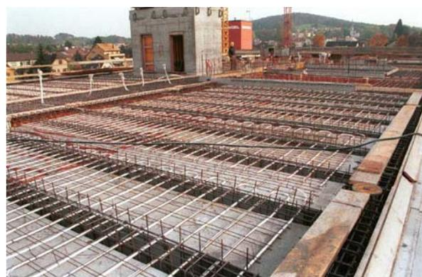
Elément de construction thermoactif avant le bétonnage.
