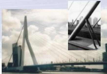
*Le pont Erasme à Rotterdam. En haut à droite: Amortisseurs visqueux passifs installés pour réduire les vibrations des câbles.*
