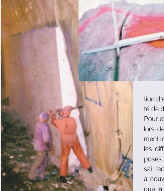
*Profond sillon dans le béton de la structure porteuse provoqué par des plis du lé d'étanchéité.*
