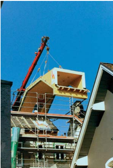
Dachstockerneuerung in einem Tag, dank Elementbauweise an der Zwinglistrasse 9 in Zürich.
