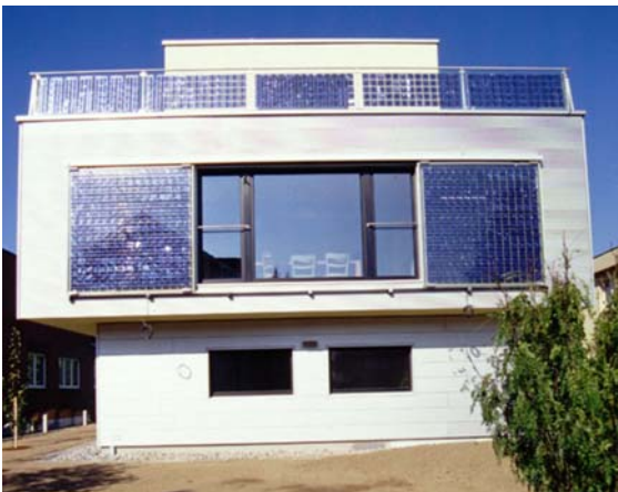
Neuentwickelter Schiebeladen mit Photovoltaik-Elementen offen, Aussenansicht.
