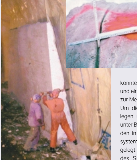
Abbruch des Tragwerks zur Kontrolle des Abdichtungssystems.
